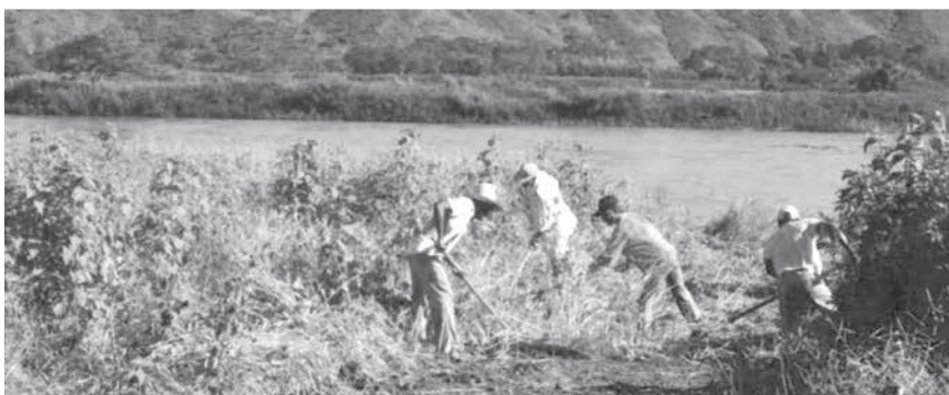
Limpeza do terreno no sentido do rio (local do 1º barracão) - 1994.
